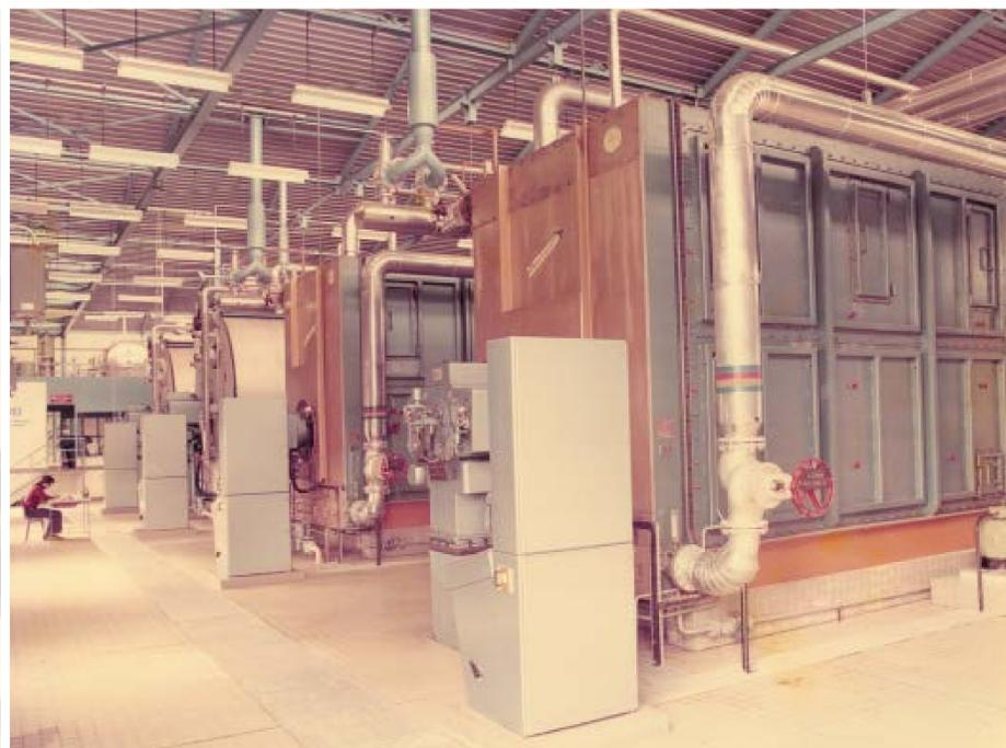
Le chauffage, la ventilation et l'air conditionné pour certains locaux spécialisés, ont nécessité l'installation de quatre générateurs d'eau et de vapeur biocombustibles et de trois groupes centrifuges à condensateurs refroidis par aéro-réfrigérants.
